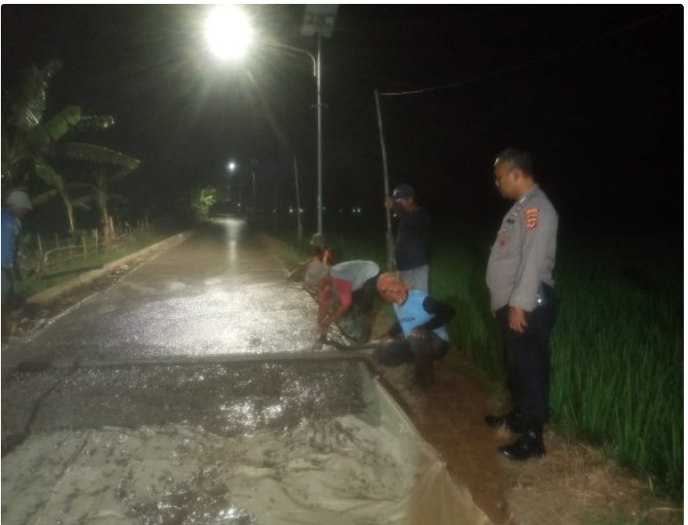
Bhabinkamtibmas Polsek Sliyeg Monitoring Pembangunan Pengecoran Jalan Desa
